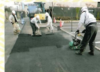
道路緊急修繕
